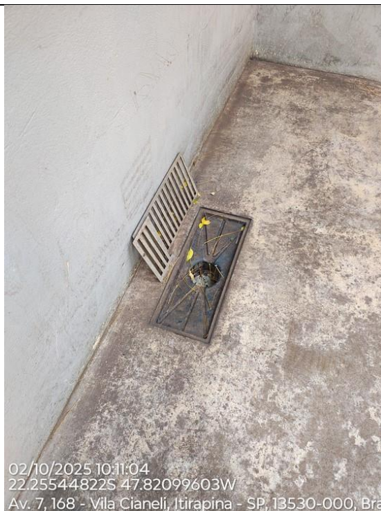
Foto 79 – Detalhe do ralo sem a grelha, é necessário a colocação da grelha para não causar entupimento pela entrada de lixo sólido ou folhas de árvores.
