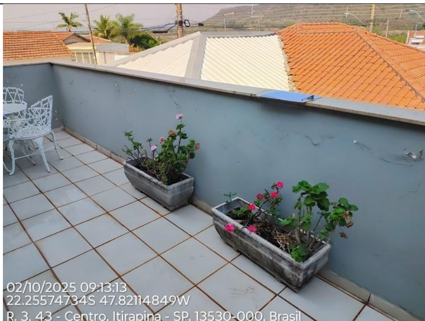
Foto 56 – Alvenaria com infiltração proveniente do vizinho. O lado externo da parede não possui impermeabilização nem pintura.
