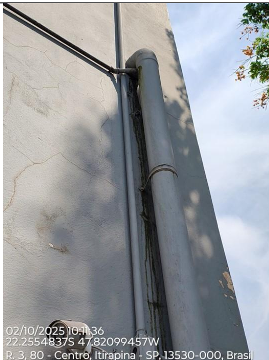
Foto 82 – Condutor de água pluvial com pequeno vazamento na curva embutida na alvenaria, junção calha/condutor.
