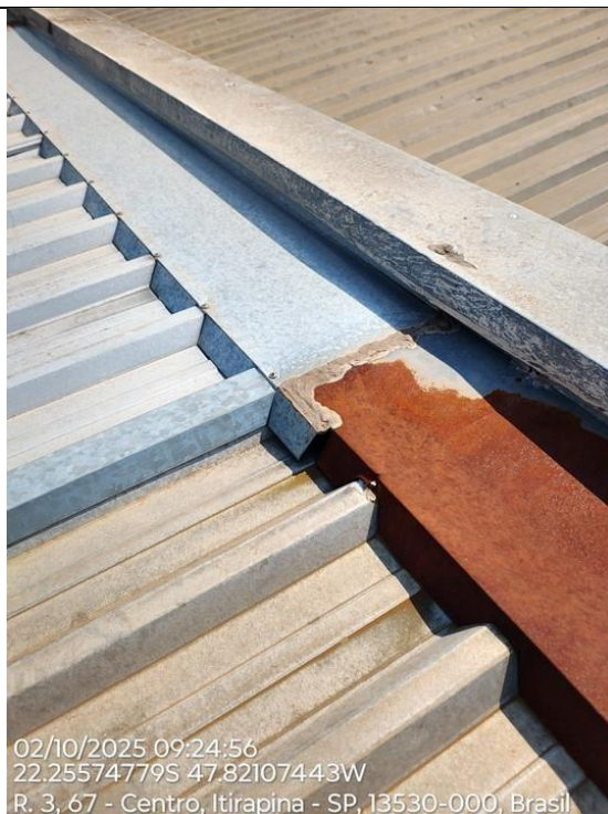
Foto 08 – Detalhe da telha nova e emenda com o antigo onde percebe-se um espaço para a entrada de água. Rufos novos com fechamento no canal da telha, isso deveria ser feito em todos os rufos.
