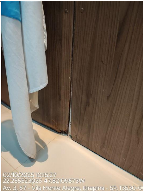
Foto 89 – Deterioração do revestimento laminado melamínico proveniente do antigo vazamento.
