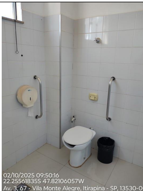
Foto 46 – Sanitário Acessível com funcionamento perfeito de toda a hidráulica. Neste ponto, para atender a nova norma de acessibilidade, falta uma barra de apoio na horizontal.
