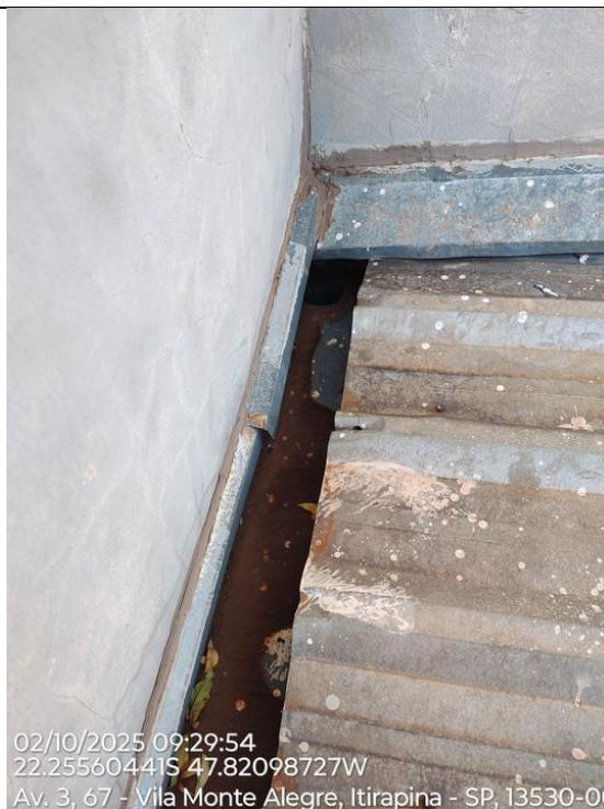
Foto 18 – Canto da cobertura do plenário, descida do condutor ok mas calha com início de corrosão.
