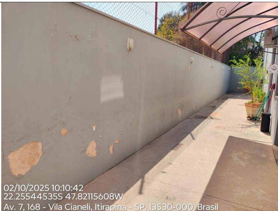
Foto 77 – Alvenaria de divisa com infiltração provavelmente do encontro da parede do vizinho – Fundos do terreno.
