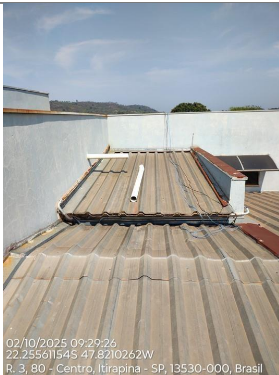
Foto 17 – Detalhe da junção da cobertura do plenário e sala de projeção.
