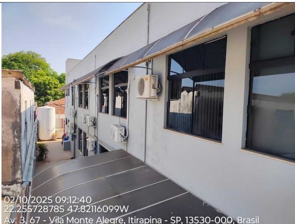
Foto 54 – Vista lateral da fachada oeste mostrando que todos os ares condicionado possuem furos na alvenaria causando infiltração de água de chuva.
