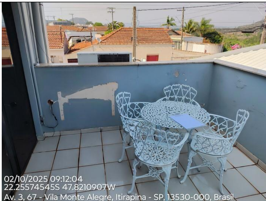
Foto 52 – Alvenaria da varanda com infiltração.
