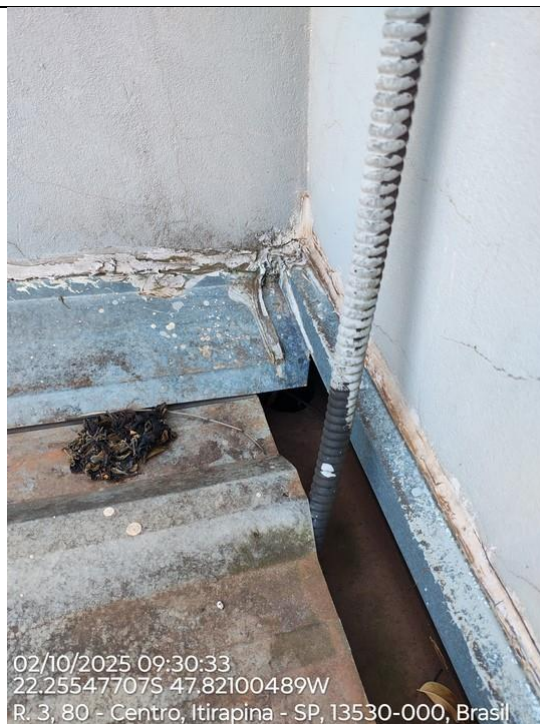
Foto 20 – Rufos de encosto siliconados mas com desgaste do tempo, condutor desobstruído mas calha em início de corrosão.
