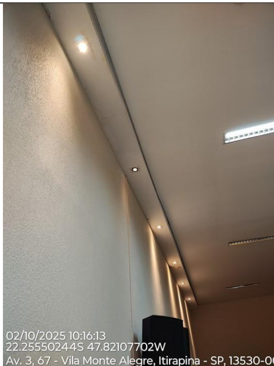
Foto 92 – Detalhe em gesso para iluminação logo abaixo da calha.
