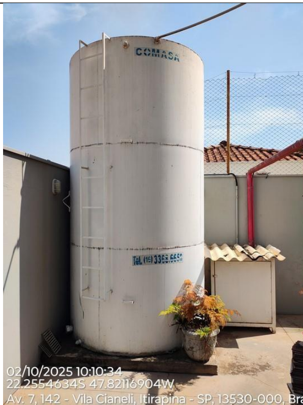
Foto 76 – Caixa d'água com pequenos pontos de ferrugem. Passar inibidor de ferrugem e pintura geral .
