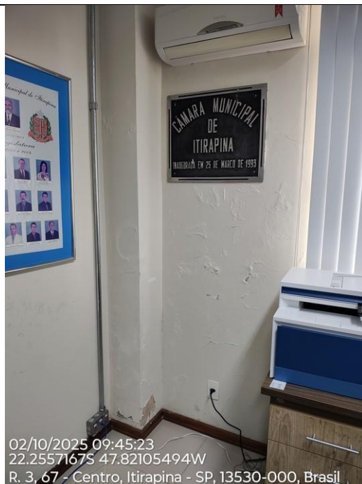
Foto 33 – Sala Assessoria 01– Infiltração proveniente provavelmente do furo executado na alvenaria para a instalação do ar condicionado.
