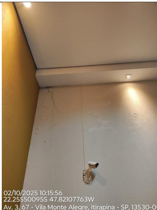
Foto 91 – Infiltração no mesmo ponto mostrado nas fotos 82 e 83. Provável vazamento na junção calha/condutor.
