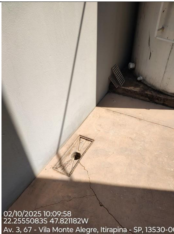
Foto 74 – Detalhe do ralo sem a grelha, é necessário a colocação da grelha para não causar entupimento pela entrada de lixo sólido ou folhas de árvores. Ralo ao lado da Caixa d'água.
