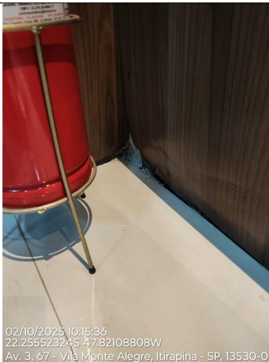
Foto 90 – Deterioração do revestimento laminado melamínico proveniente do antigo vazamento.
