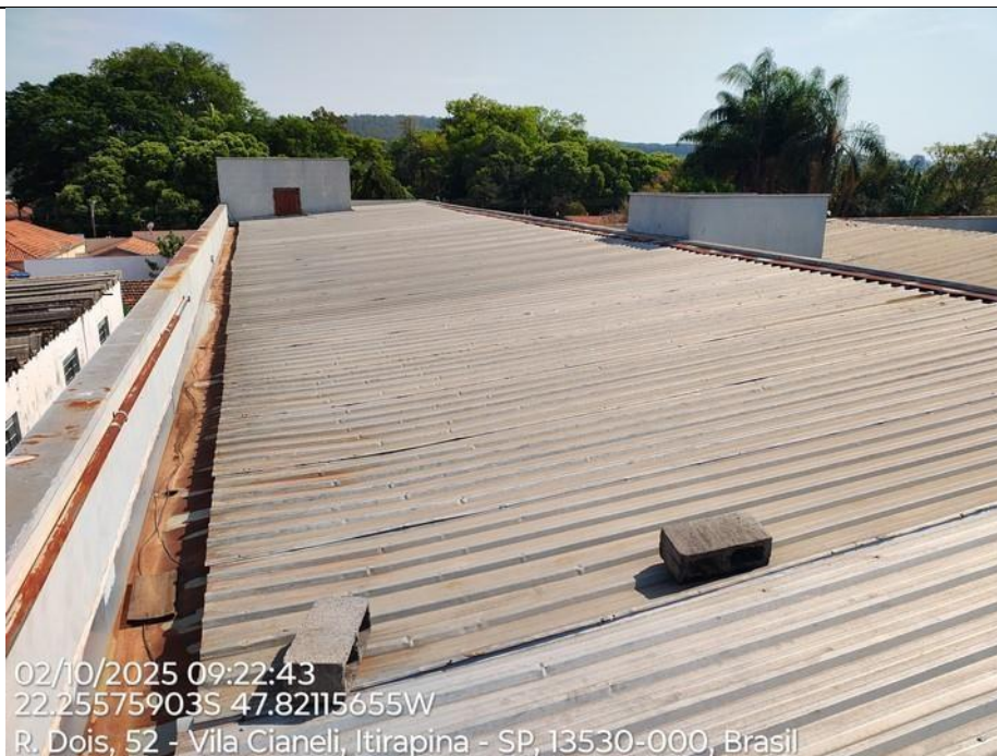
Foto 04 – Vista geral das telhas sanduíches acima das salas dos vereadores. Nota-se uma telha que foi substituída, mas a junção das telhas antigas e a nova sem fixação por parafusos e blocos de concreto para mantê-las na posição.
