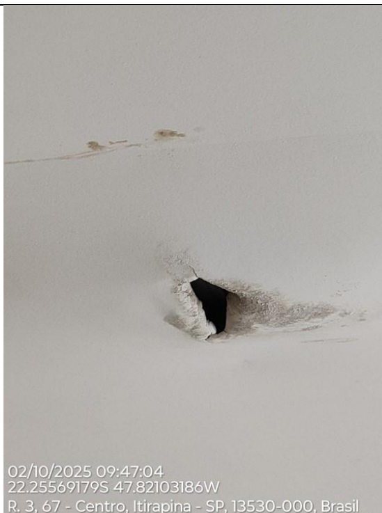
Foto 29 – Detalhe do furo no forro de Drywall.
