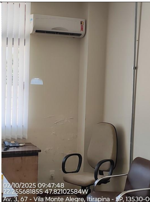
Foto 35 – Sala Assessoria 02 - Infiltração proveniente provavelmente do furo executado na alvenaria para a instalação do ar condicionado.
