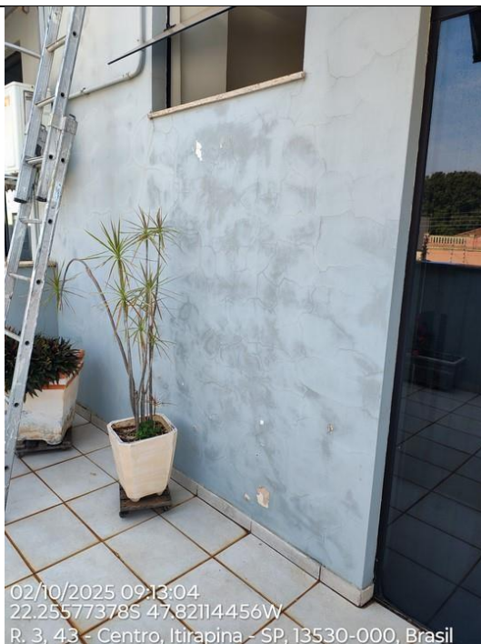
Foto 55 – Alvenaria com infiltração.
