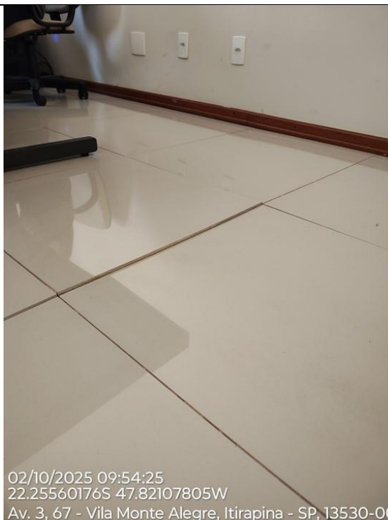
Foto 43 – Detalhe do “descolamento” do piso. Retirar, raspar e reassentar com argamassa industrial.
