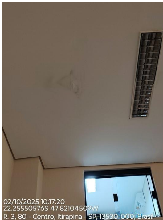
Foto 98 – Infiltração na telha não perceptível na foto 17.
