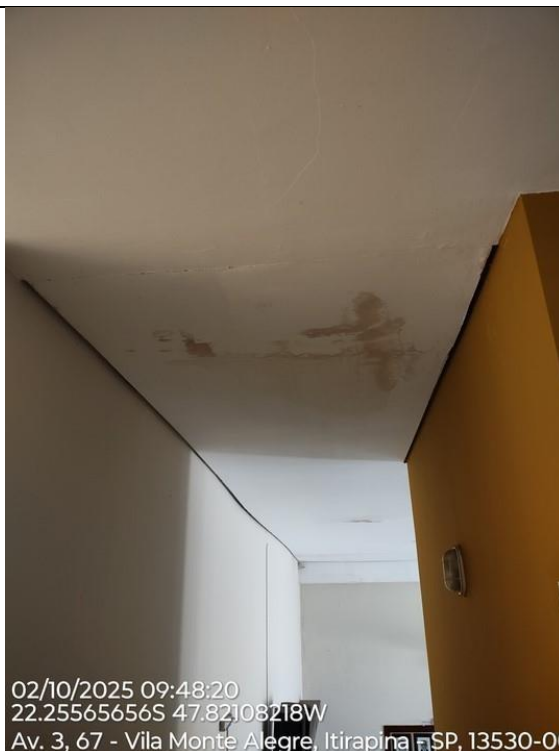
Foto 31 – Manchas no forro de drywall proveniente de goteiras.
