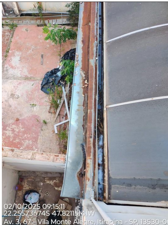
Foto 62 – Calha da cobertura da garagem com caimento irregular causando acúmulo de água e futuro processo de corrosão.
