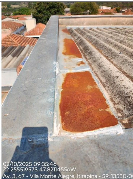
Foto 22 – Rufos em início de processo corrosivo.
