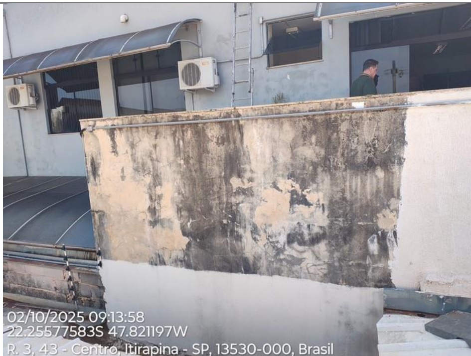
Foto 58 – Vista da alvenaria do lado do vizinho sem impermeabilização adequada causando infiltração na alvenaria.
