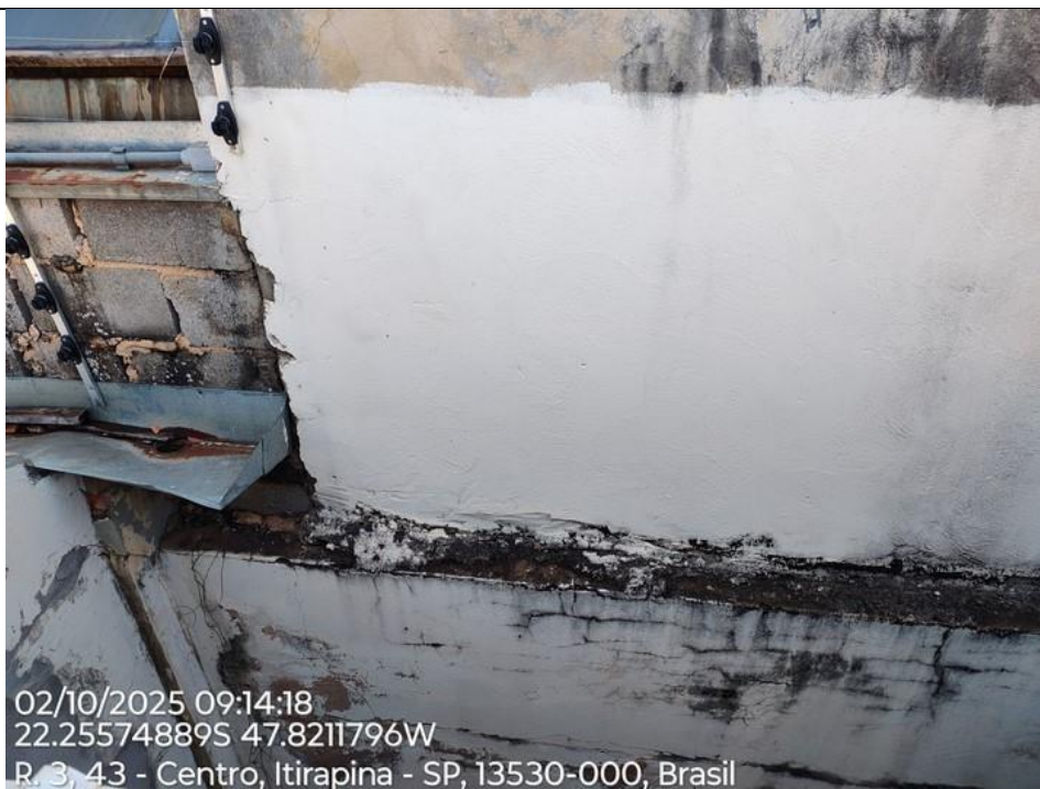
Foto 60 – Ponto crucial da infiltração, encosto entre alvenarias vizinhas sem proteção por rufo, encontro de alvenaria sem reboco e bocal da calha sem condutor.
