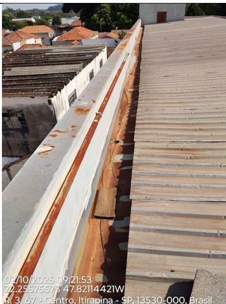
Foto 02 – Rufo pingadeira, rufo de encosto e calhas iniciando o processo de corrosão. Telhas amassadas devido a circulação de pessoas para passagem de fiação.
