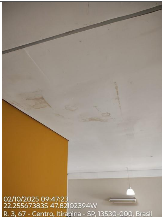
Foto 30 – Manchas no forro de drywall proveniente de goteiras.
