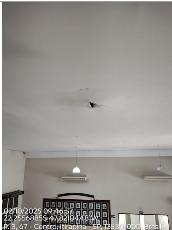
Foto 28 – Goteira pontual proveniente de um parafuso ou sobreposição de telha com vazamento.
