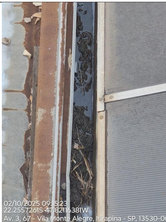
Foto 63 – Detalhe do acúmulo de água e sujeira na calha, falta de manutenção.
