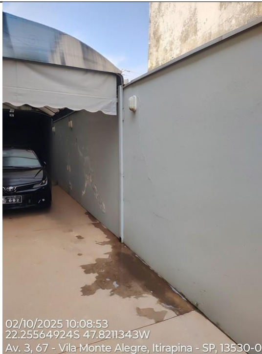
Foto 70 – Vista do muro de divisa onde começa a garagem e onde a alvenaria não está rebocada do lado do vizinho.
