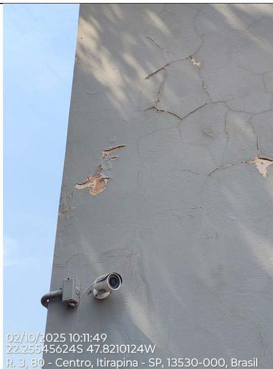
Foto 83 – Prolongamento de infiltração causado pela junção calha/conductor da parede lateral.
