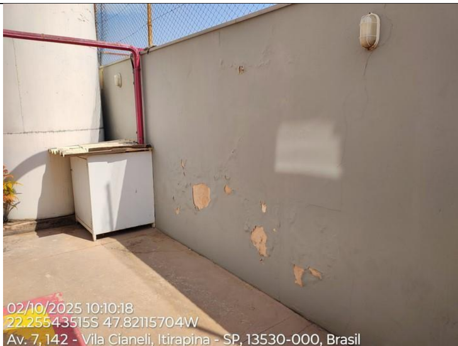
Foto 75 – Alvenaria de divisa com infiltração – Fundos do terreno.
