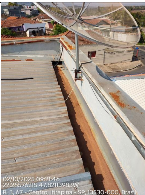
Foto 01 – Calhas com tamanho apropriado para o volume de água, aparentemente sem vazamentos mas iniciando o processo de corrosão.
