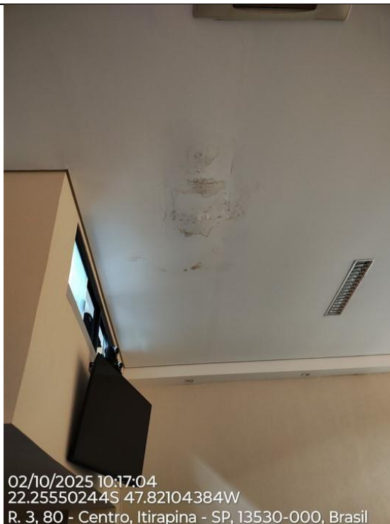
Foto 96 – Infiltração na telha não perceptível nas fotos 14 – 16 e 17. Abrir o forro para detectar este vazamento
