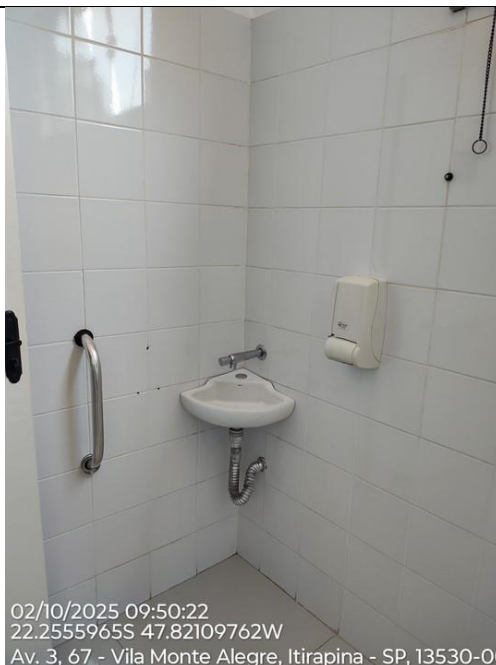
Foto 47 – Sanitário Acessível com funcionamento perfeito de toda a hidráulica. Neste ponto, para atender a nova norma de acessibilidade, falta uma barra de apoio.
