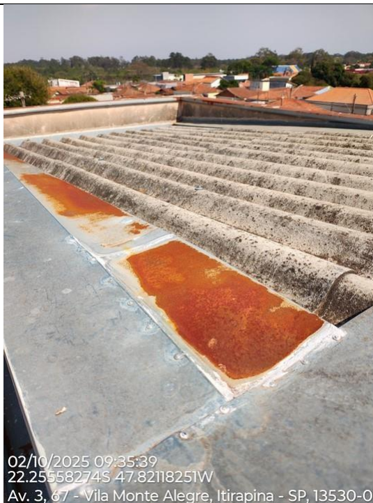
Foto 21 – Telhado da caixa d'água em fibrocimento em bom estado. Rufos em início de processo corrosivo.
