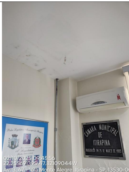
Foto 34 – Manchas de infiltração na laje. Coincide com a emenda da telha nova que está sem parafuso de fixação e com blocos de concreto para mantê-la na posição.
