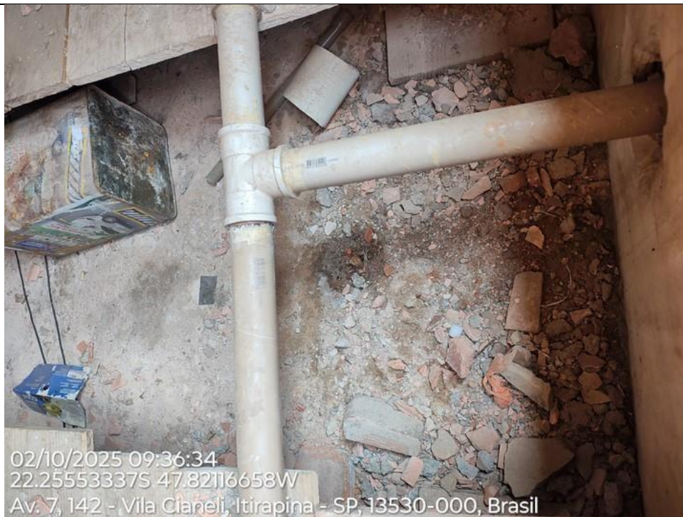
Foto 23 – Caixa d' água. Tubulação com pequeno vazamento na junção.
