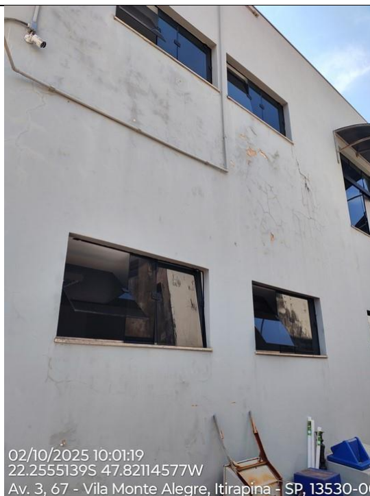
Foto 64 – Corredor externo, fachada oeste com infiltração.
