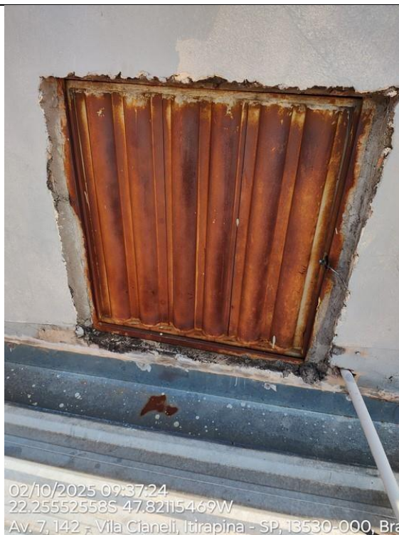
Foto 24 – Alçapão da caixa d'água em processo de corrosão e sem arremate no reboco.
