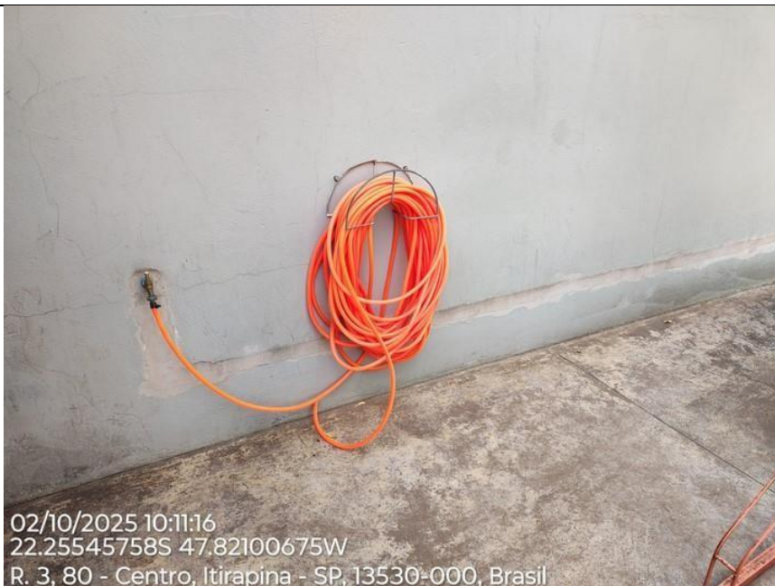
Foto 80 – Detalhe da alvenaria onde foi instalado rede de água, passar massa, fundo preparador e pintar.
