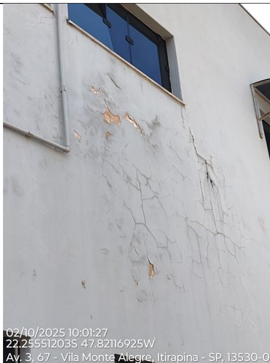
Foto 65 – Local onde passa a tubulação das descargas dos sanitários. Abrir alvenaria para detectar possível vazamento.
