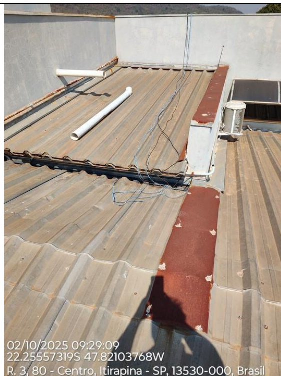
Foto 16 – Detalhe da junção da cobertura do plenário e sala de projeção.
