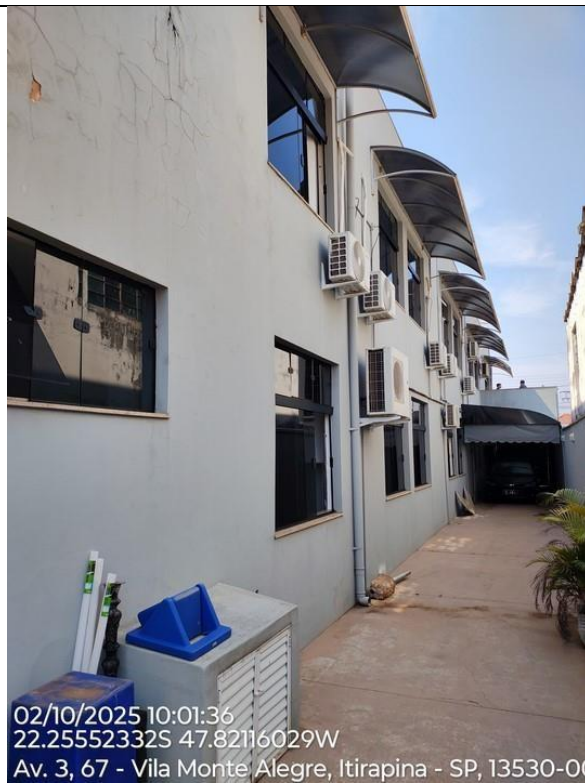
Foto 66 – Vista lateral da fachada oeste mostrando que todos os ares condicionado possuem furos na alvenaria causando infiltração de água de chuva.
