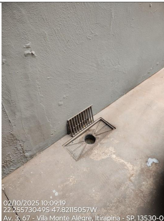
Foto 73 – Detalhe do ralo sem a grelha, é necessário a colocação da grelha para não causar entupimento pela entrada de lixo sólido ou folhas de árvores.
