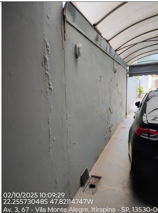
Foto 72 – Detalhe de toda a infiltração conforme descrito nas fotos 57 a 61.
