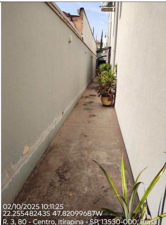
Foto 81 – Detalhe da alvenaria onde foi instalado rede de água, passar massa, fundo preparador e pintar
