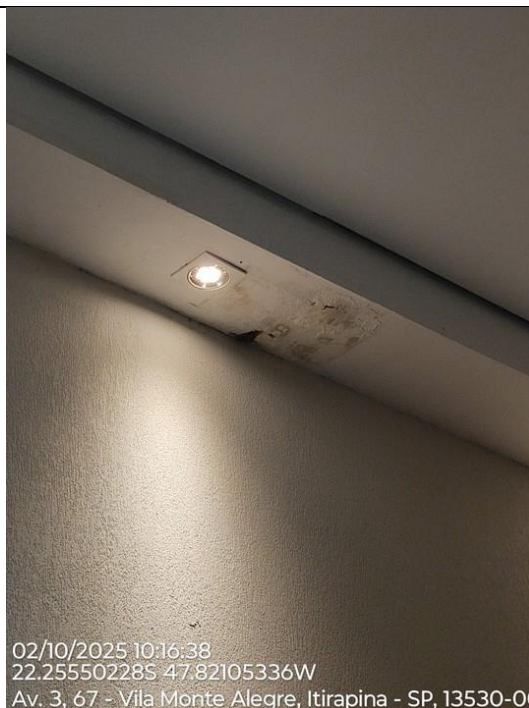
Foto 95 – Vazamento provavelmente na junção calha/condutor.
